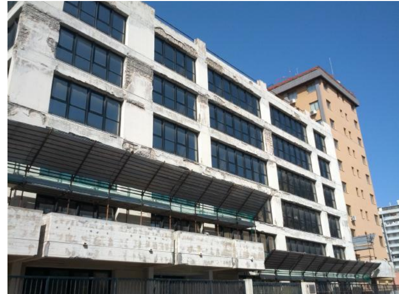
Figura 5 Nord Ovest (Via Morselli)
