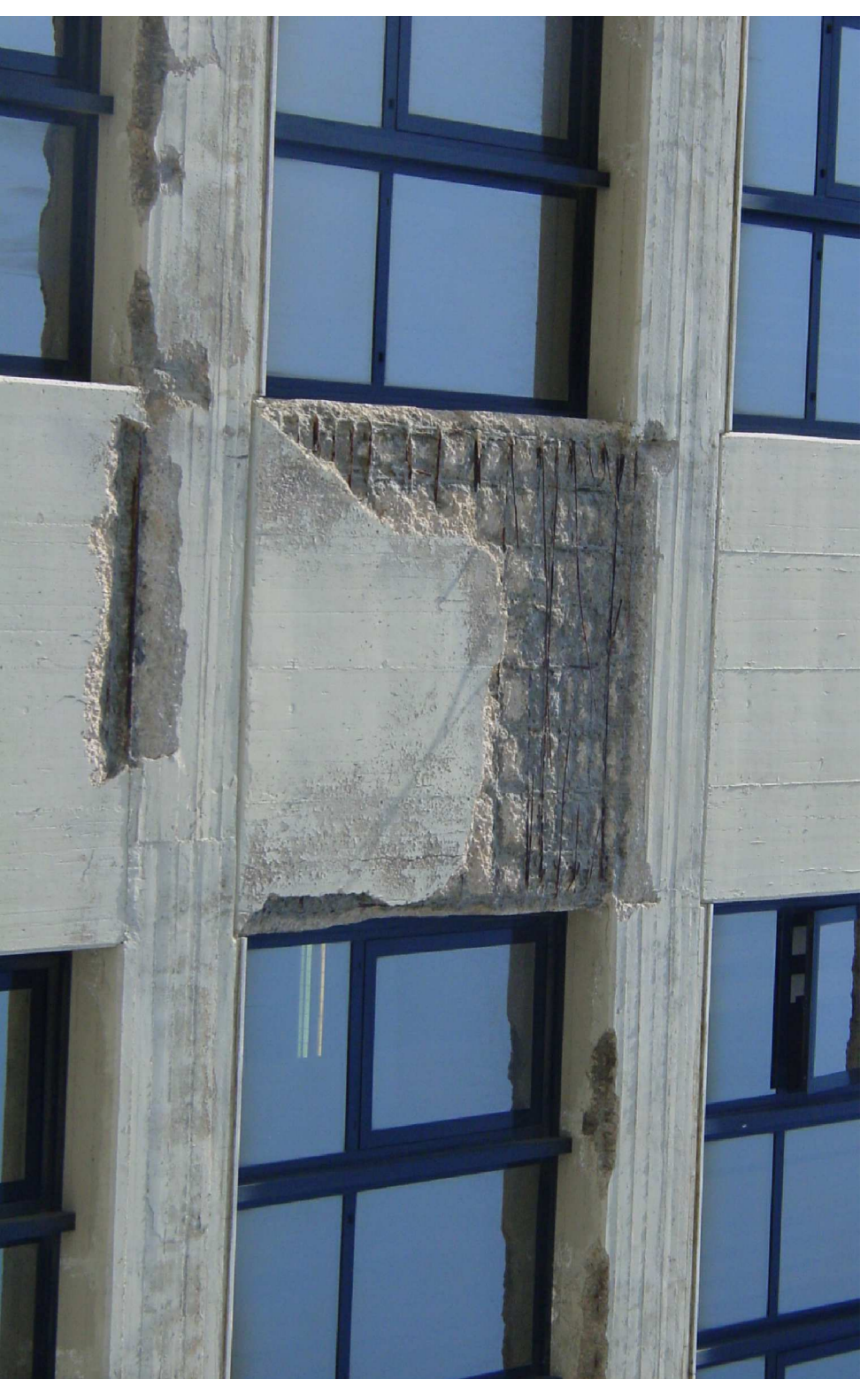
Foto 3 - Dettaglio degrado trave e pilastro
