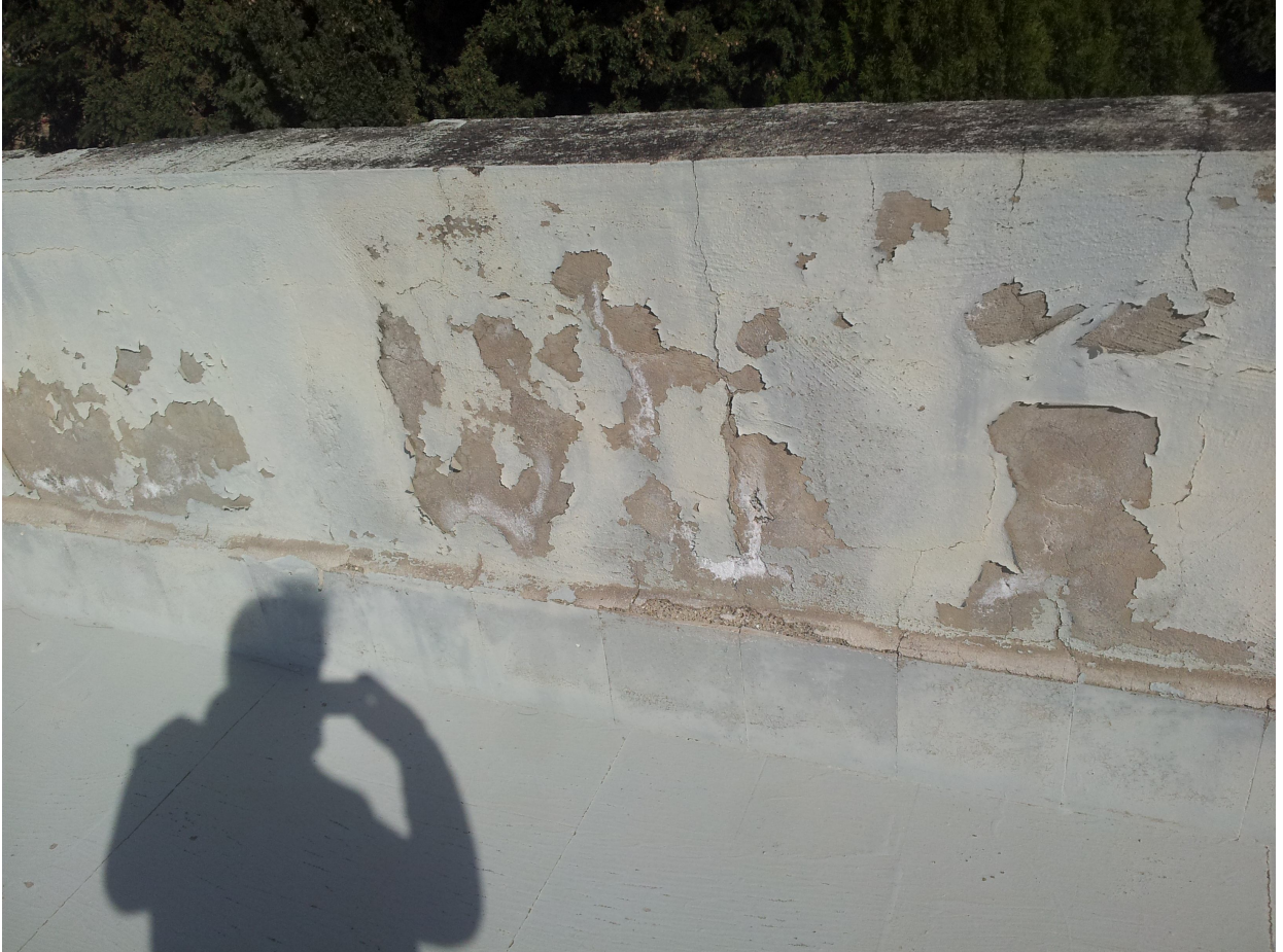
FOTO N°4 – PARTICOLARE PARAPETTO INTERNO TERRAZZO
