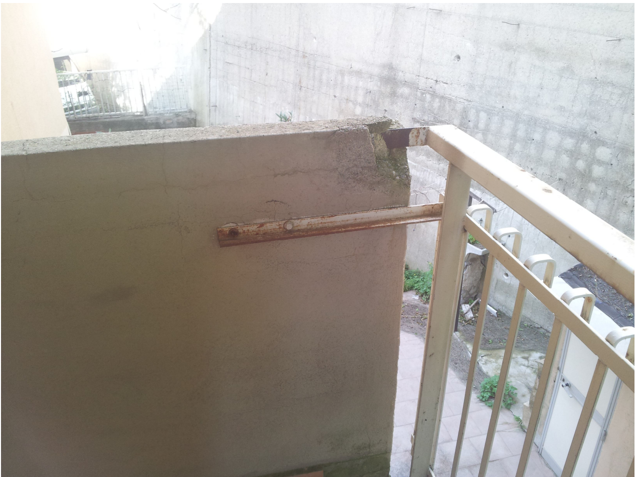
FOTO N°6 – PARTICOLARE INNESTO “ZANCA” RINGHIERA BALCONI
